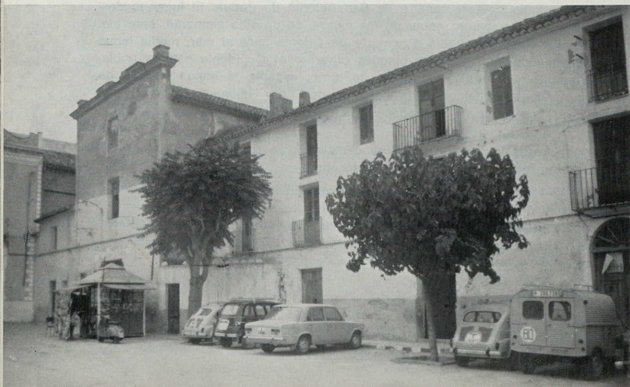
Edificios del antiguo convento de San Antonio, Juzgados y Casa Cuartel de la Guardia Civil
