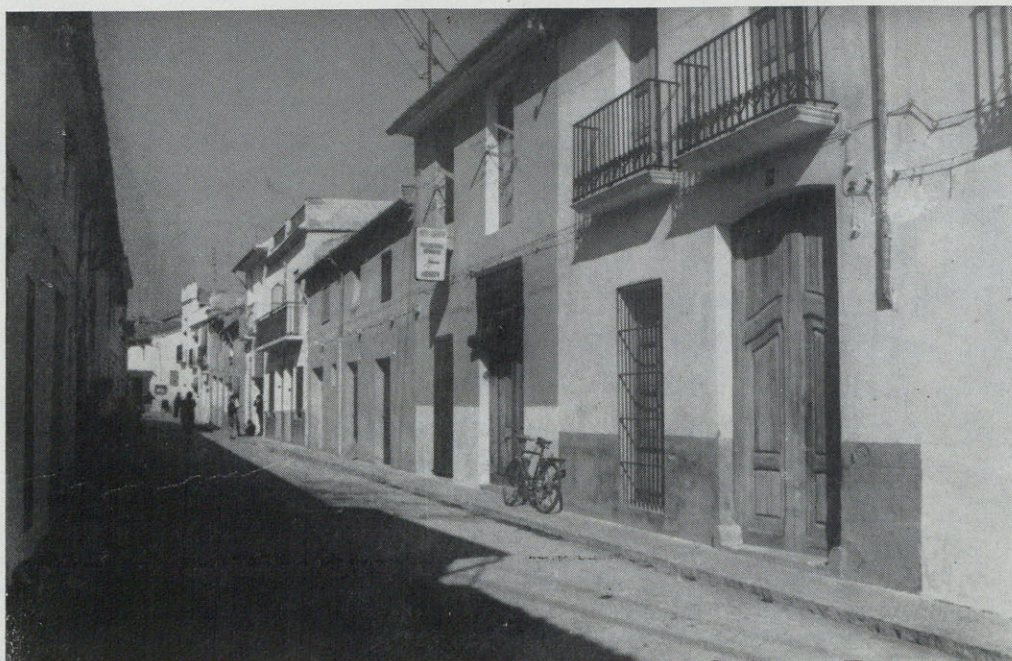
Calle Carrasqueta después de las obras de ensanche
